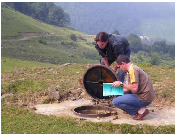
Visite de contrôle d'un captage et d'un périmètre de protection
